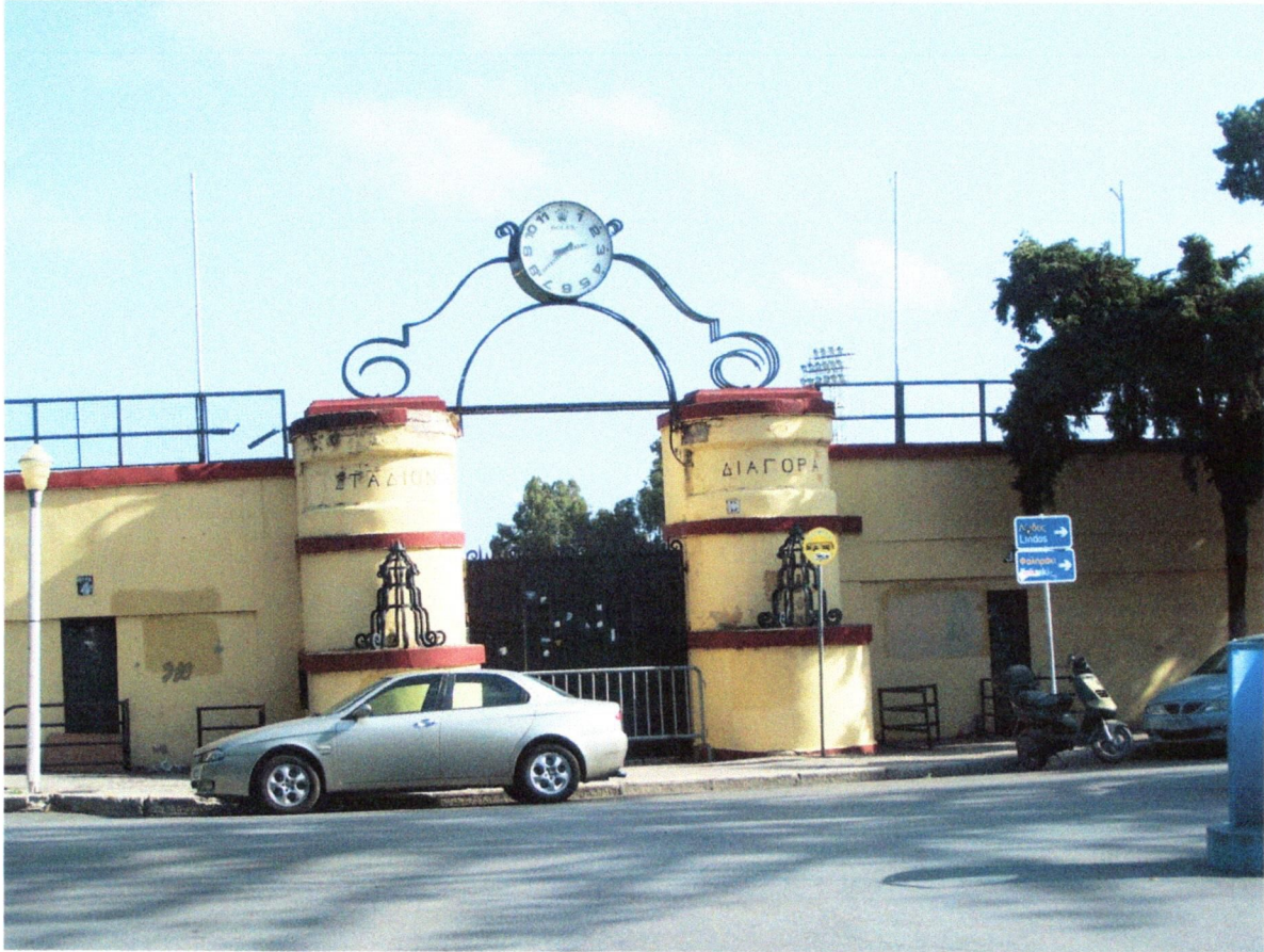
Εικ. 03. Όψη της Δυτικής εισόδου του συγκροτήματος με το χαρακτηριστικό ρολόι.
