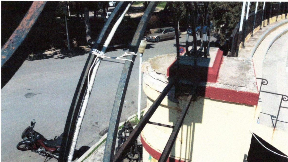
Εικ. 04. Ό.π. Διακρίνονται οι φθορές στα επιχρίσματα και οι ρωγματώσεις, καθώς και η ανάγκη ανανέωσης του χρωματισμού των σιδηρών επιφανειών.
