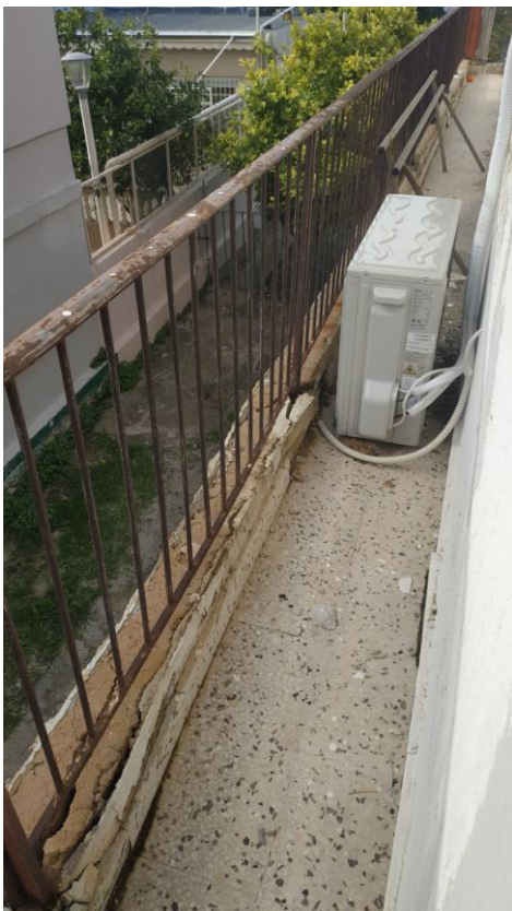
Φ6: Κιγκλιδώματα μπαλκονιών με εμφανή σημάδια διάβρωσης
