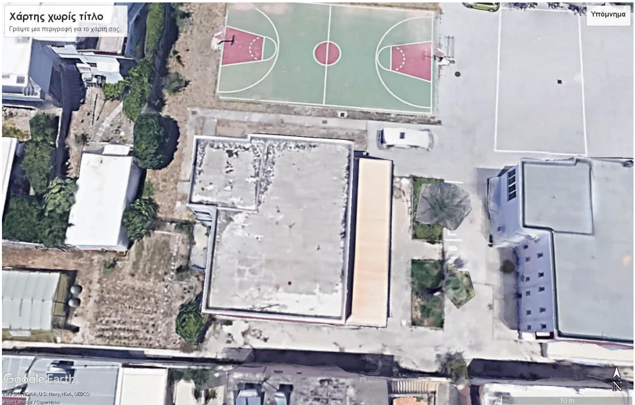
Φ5: Η μόνωση του δώματος ΚΔΑΠ ΑΜΕΑ Αγίου Νικολάου
