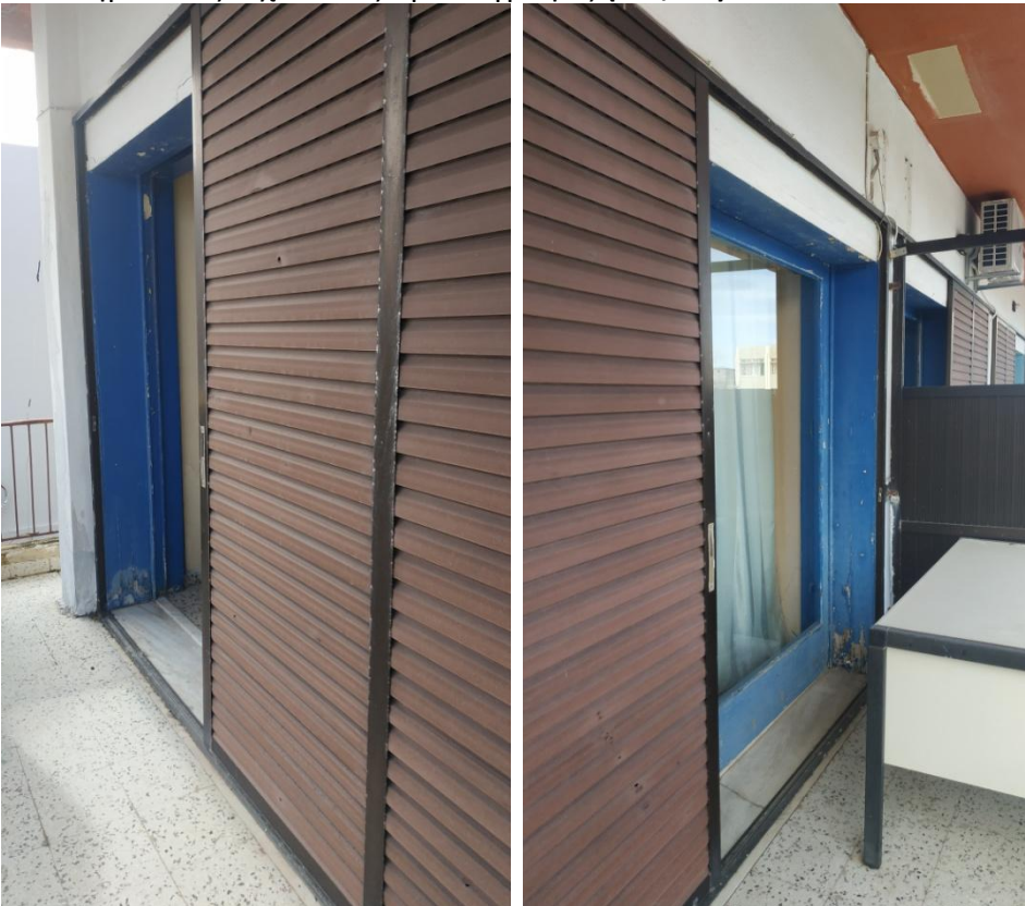
Φ8, Φ9: Παλαιά ξύλινα κουφώματα και παλαιά αλουμινένια πατζούρια στα ανοίγματα ορόφου και ισογείου.
