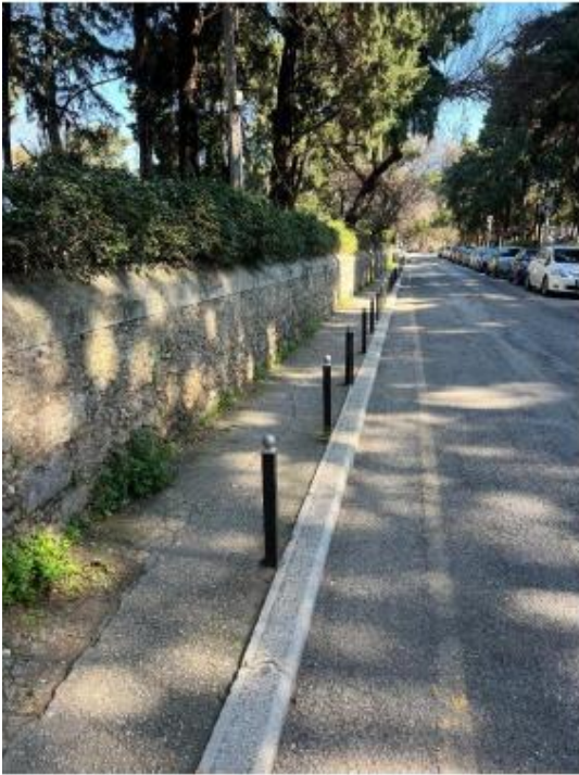
Πεζοδρόμιο προς ανακατασκευή
